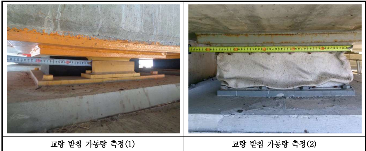
【사진 35.3.15】 교량받침 이동량 측정
