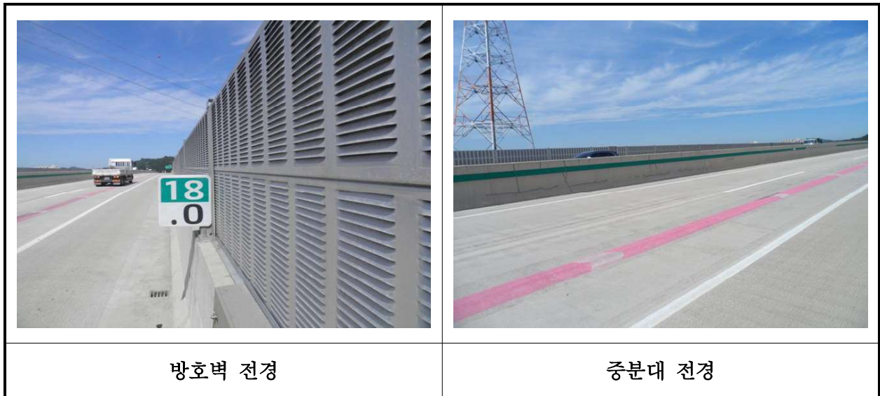
【사진 35.3.23】 방호벽 및 중앙분리대 전경
