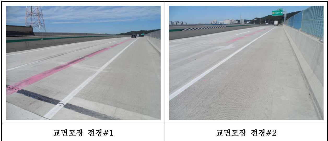
【사진 35.3.19】 교면포장 전경
