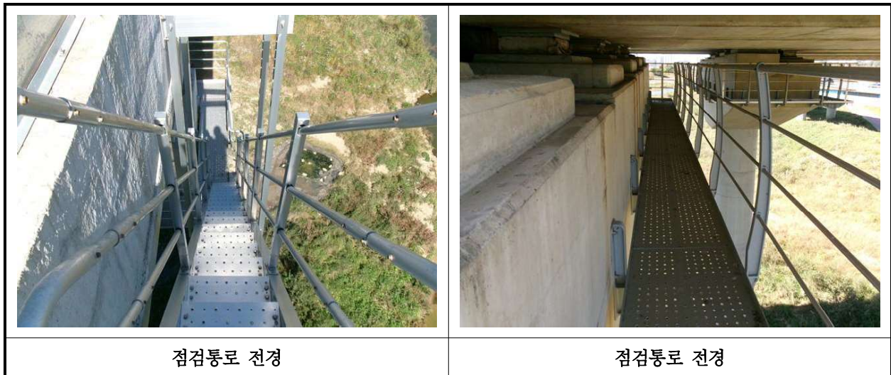
【사진 35.3.25】 교량 점검시설 전경
