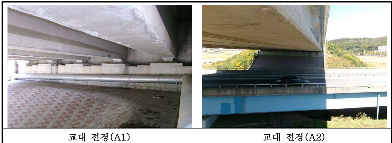
【사진 35.3.8】 교대 전경
