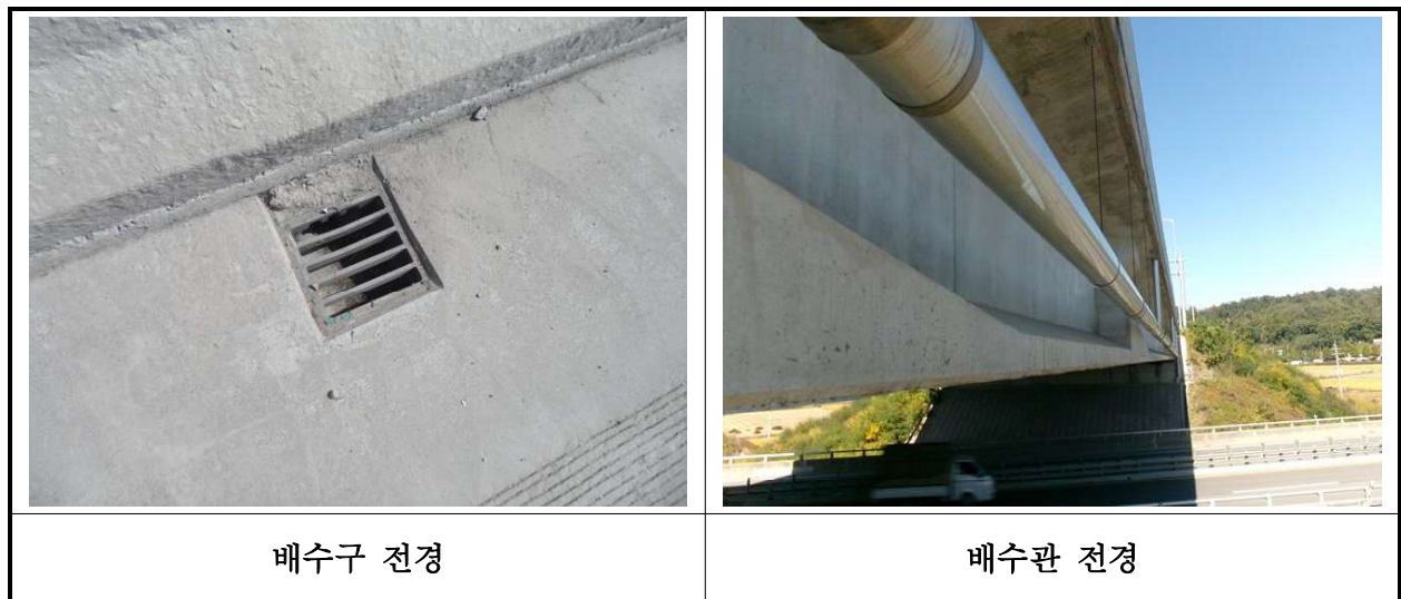
【사진 35.3.21】 배수시설 전경
