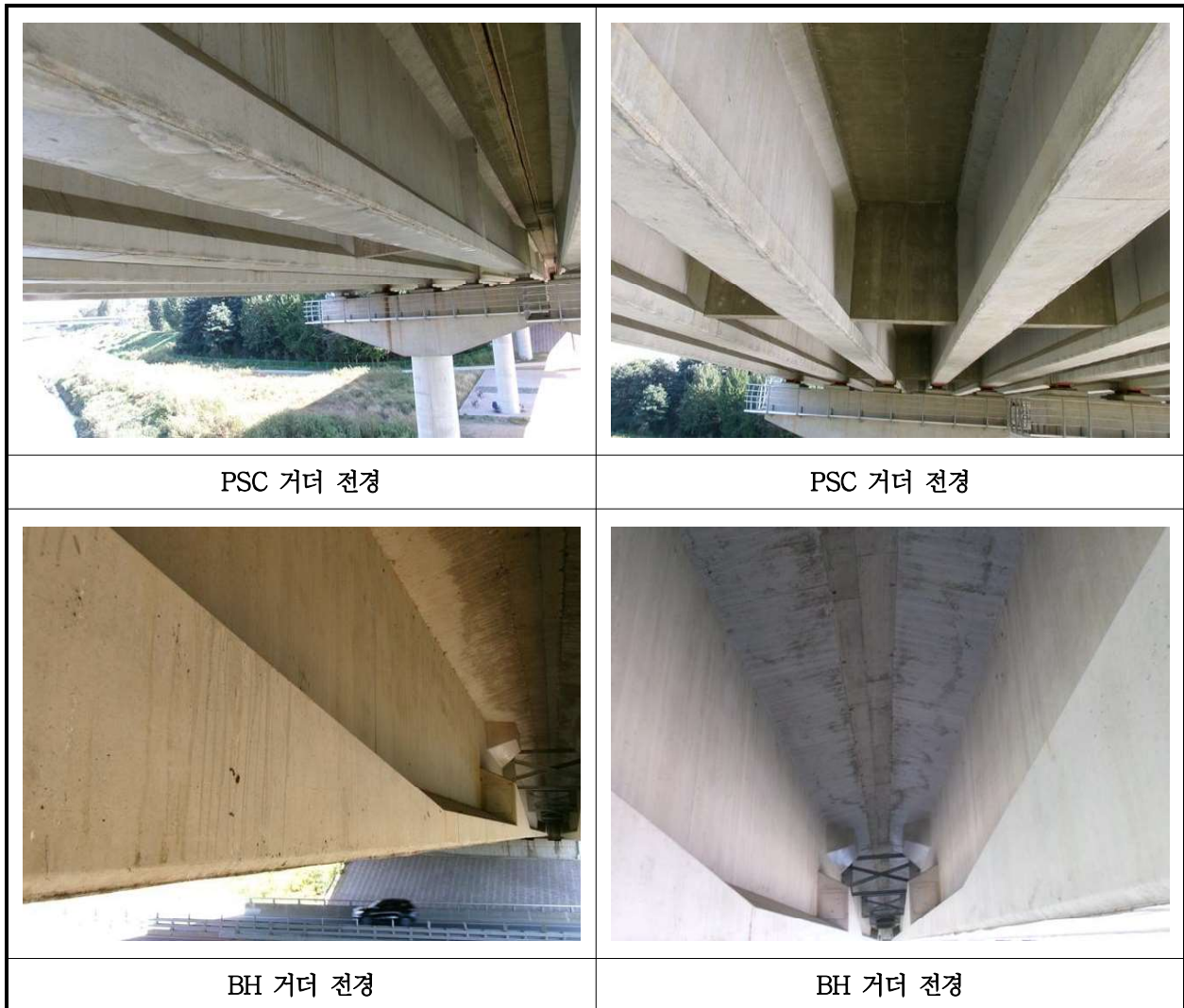
【사진 35.3.4】 거더 전경
