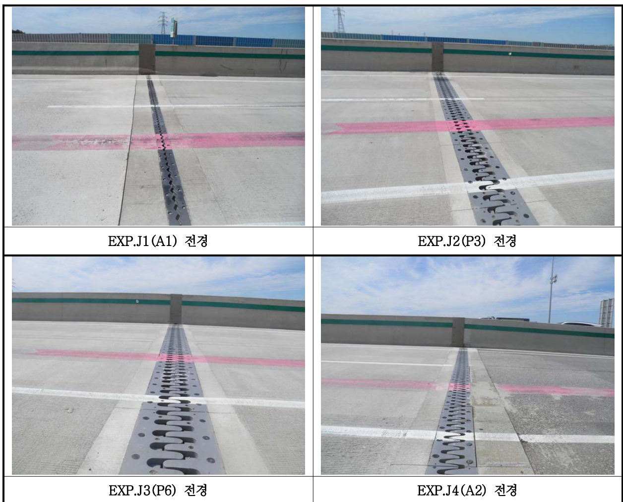
【사진 35.3.16】 신축이음장치 전경
