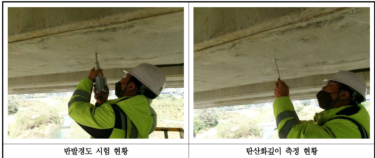
【사진 35.4.1】 콘크리트 내구성조사 현황
