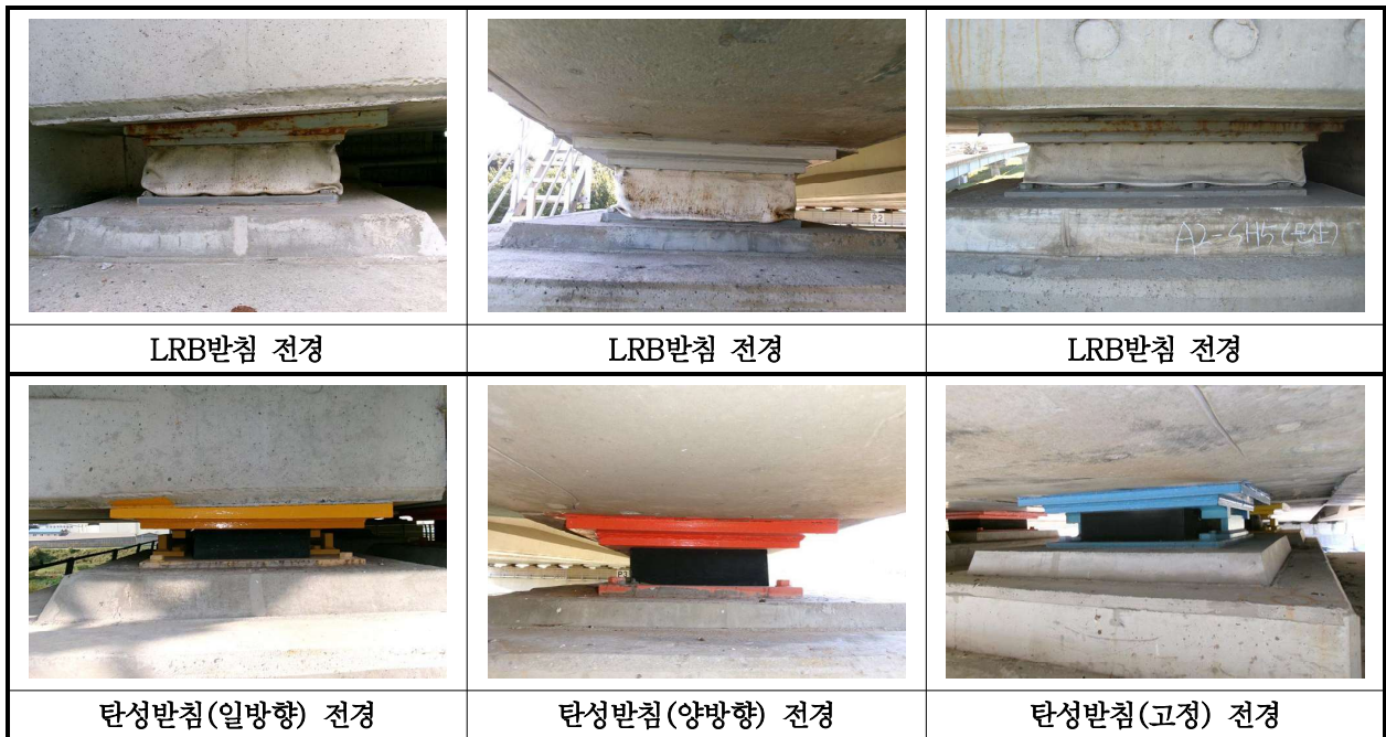
【사진 35.3.12】 교량받침 전경
