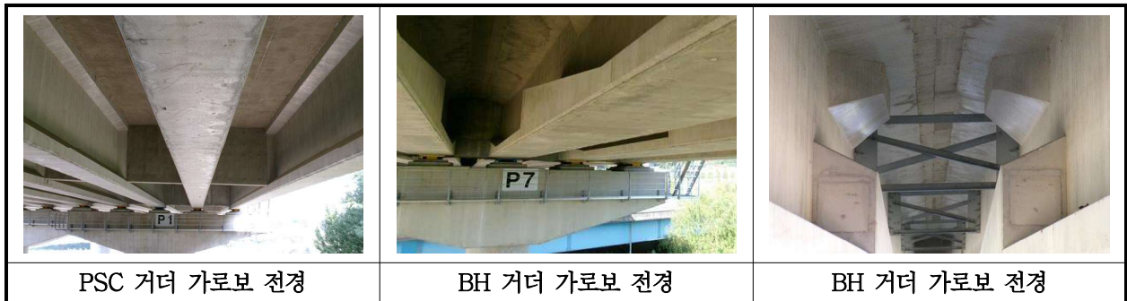
【사진 35.3.6】 가로보 전경
